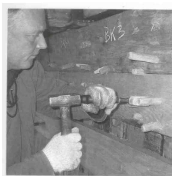
Træsnagle indenbords tilkugges. Her er naglen savet af til ca. 4 tommer overlængde. Tømreren uddanner en kile ved at hugge sig ind fra begge sider til der kan stå et par millimeter tilbage
