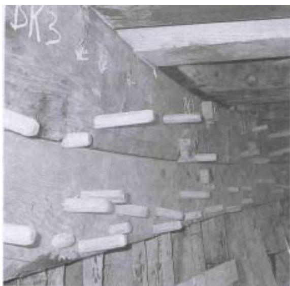
Skørnagler er ligeså essentielle i et træskib som stemmestokken er det i Arne Gotveds violin. Men da skørnaglens funktion er en helt anden end trænaglernes, skal de nok få sin omtale ved en anden anledning.
