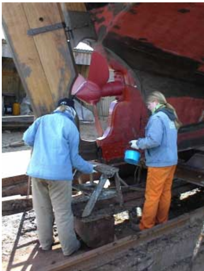
Nymale skrue og nyt rør Foto: Henning Gerken
